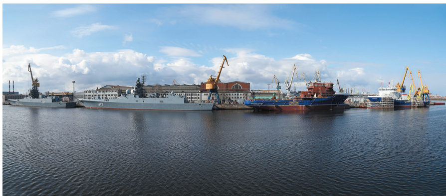
В рамках I этапа модернизации Северной верфи планируется построить эллинг для кораблей и судов спусковой массой до 25 тыс. тонн. Фото: nordsy.spb.ru
